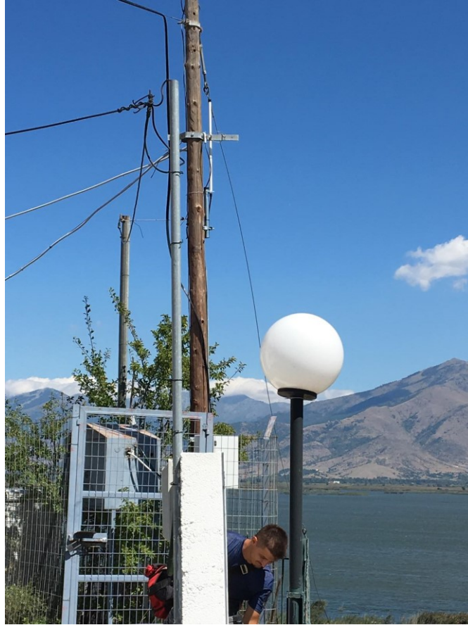
Εικόνα 3. Τοποθέτηση του συστήματος στον Άγιο Αχίλλειο
